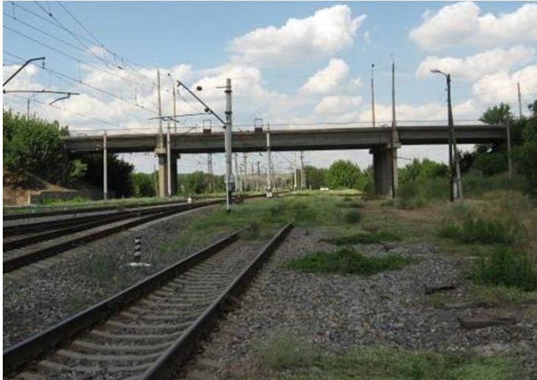
Рис. 3. Шляхопровід над залізницею
