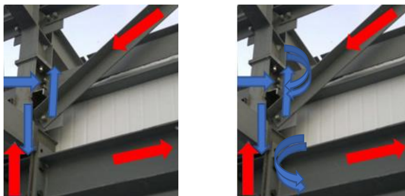
Рис. 3. Схеми можливо розподілу зусиль у вузлі
