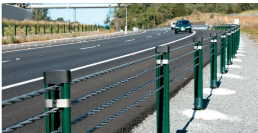
Рис. Загальний вид бар'єрного огородження з металевих тросів (WRSB)
