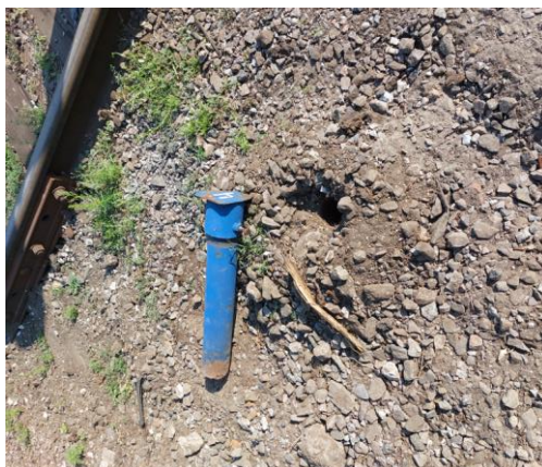
Рис. Пошкоджена режимна свердловина одному з ОЕЗ
