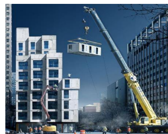
Рис. 8. Монтаж модулів
